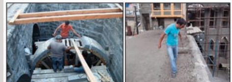
Mutfak kemeri yapılıması ve yapılan toprak damın loğlanması-2012
